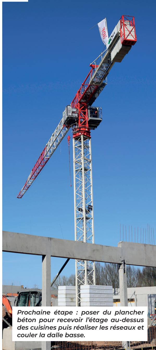
*Prochaine étape : poser du plancher béton pour recevoir l'étage au-dessus des cuisines puis réaliser les réseaux et couler la dalle basse.*
